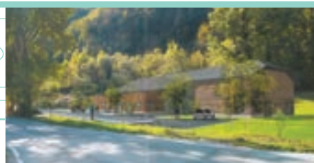
> Construction de l'abattoir à Sassis
