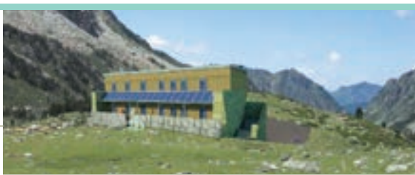
> Construction du refuge d'Aygues Cluses
